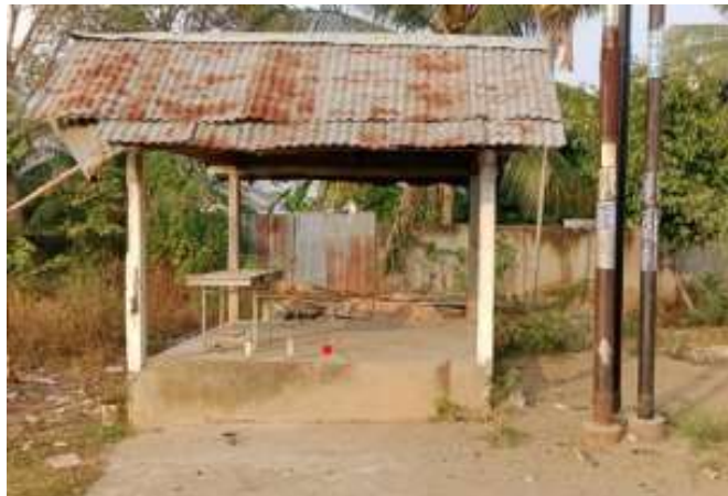
Gambar 1. Kondisi poskamling RT.60 Kelurahan Sukajaya Kecamatan Sukarami Sebelum Renovasi
