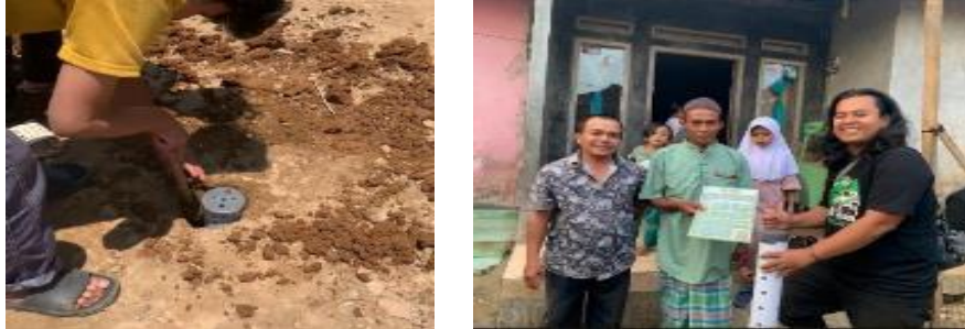
Gambar 3. Pemasangan Lubang Resapan Biopori
